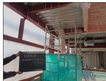
硬質発泡ウレタン吹付状況
